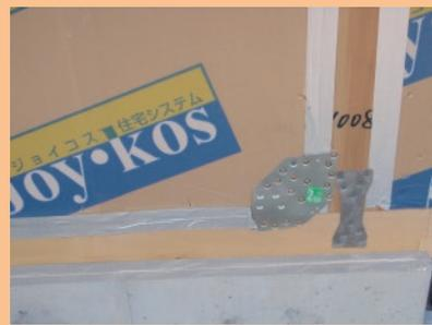
筋交い入りのパネルと柱をプレートで固定しています
