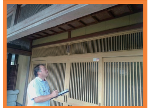
K様宅 定期点検中
