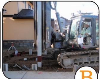
Ⓑ【11月4日】地盤調査の結果、地盤が弱い為、補強工事をする事に。そこでPC杭というコンクリート製の杭を地中に打込む工事が行われた。約130本以上の杭を強固な地盤に届くまで打込んでいく。
