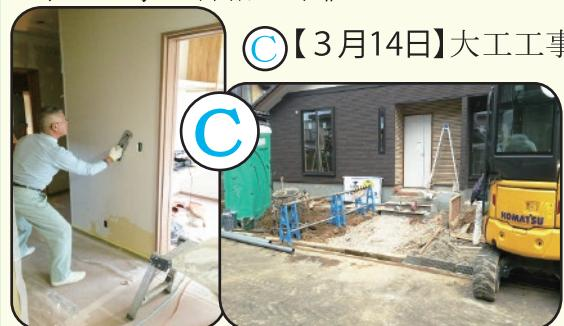
(C)【3月14日】大工工事は終わり、内装工事は仕上げ工事を進めている。親世帯の玄関は珪藻土仕上げで、調湿効果も期待出来る。クロスのような継ぎ目は無く、左官屋さんが付ける模様が味わい深い。外構はアプローチや、駐車スペースのコンクリート工事を進めている。仮設の玄関ドアはハウスクリーニング後に取り替える予定だ。
