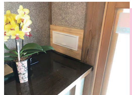
◀ 土壁には編み込んだ竹以外に下地がないので両隣の柱が見えるまできれいに壁を取り、木枠を柱に固定しました。外部は周囲をシーリング処理にて対応しました。
