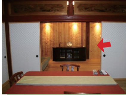
▲ 殴り彫りの板材を張った壁は間接照明で魅力的に演出。(矢印部分)
