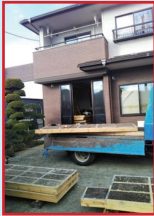
被災した『チャコの家』からパネルを搬出する様子
