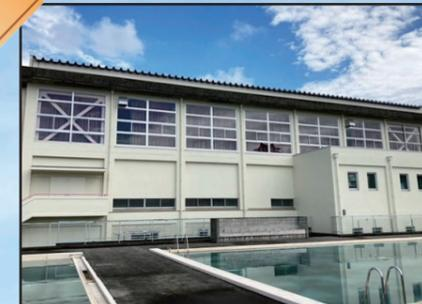
既存の窓から漏水する為、夏休み中にサッシの入替と換気扇の取付と周辺の外壁の塗装を行いました。
