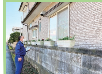
H様の外壁点検
