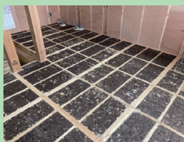
105ミリ床断熱パネルの様子
