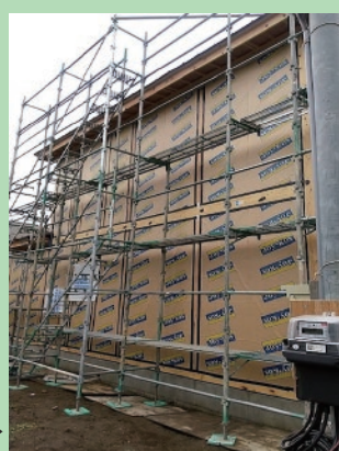
120ミリ壁断熱パネルの様子→
