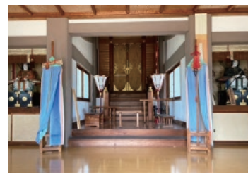
① 社殿内の漆喰壁を塗り替える
