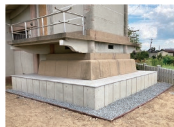
② 台座を補修し、化粧砂利を引く
