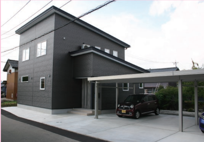
I 様邸新築工事『チャコの家』
