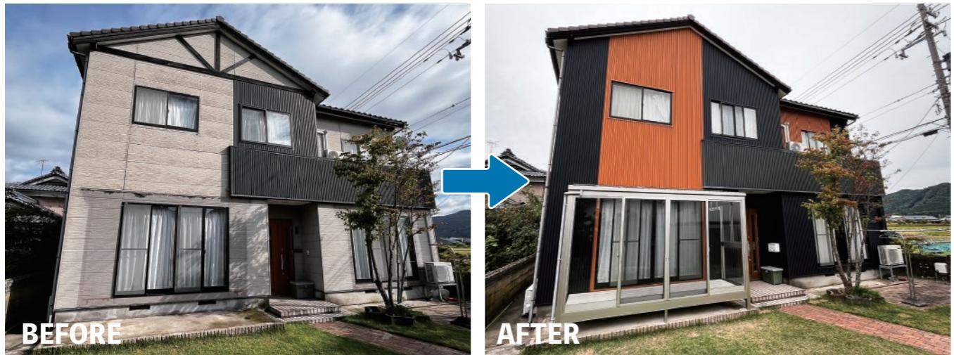
古く傷んだ外壁を張替えたいとのご相談をいただき、風を受けやすく傷みが目立っていた南面を張替えました。また、既存の木造サンルームも取り壊して、アルミ製のサンルームを新設しました。外壁のデザインは旦那さまのご希望で、ブラックとオレンジのツートーンに仕上げて上品な印象に生まれ変わりました。
